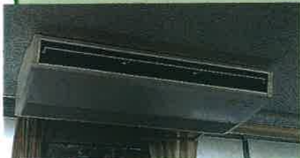
特別教室エアコン設置
